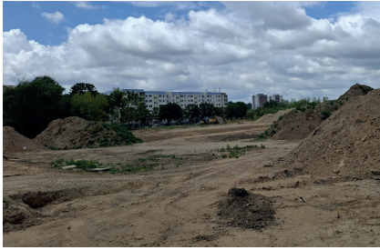
Baustelle vom Schulneubau der ISS, Stand Juli 2026
