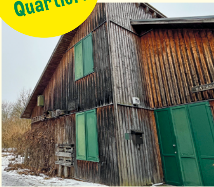
Die Außenfassade des Naturschutzzentrums Schleipfuhl wird saniert, Foto: Regina Friedrich
